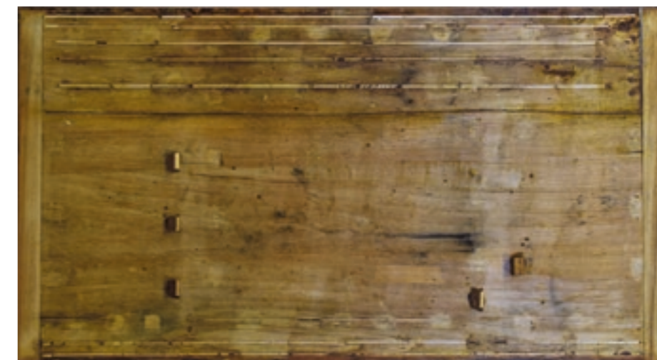
Intervento strutturale sul piano
