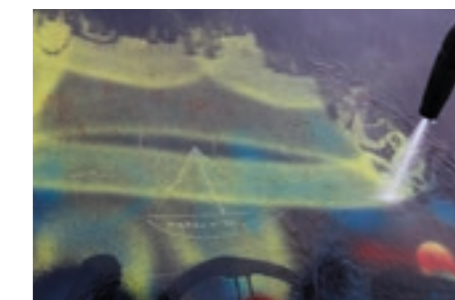
Eliminazione di alcuni graffiti tramite l'utilizzo di idro-pulitrice
