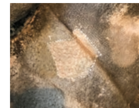
Prove di rimozione del calcare. In evidenza la lavorazione con lo scalpello e la subbia e una patina di colore ocra
