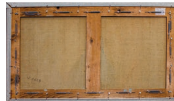
Verso del telaio dell' Immacolata dopo l'applicazione del sistema di tensionamento elastico a scorrimento perimetrale
