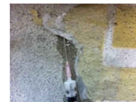
Operazioni di consolidamento dell'intonaco
