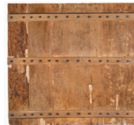
Dopo il risanamento del supporto con applicazione di nuove traverse lamellari
