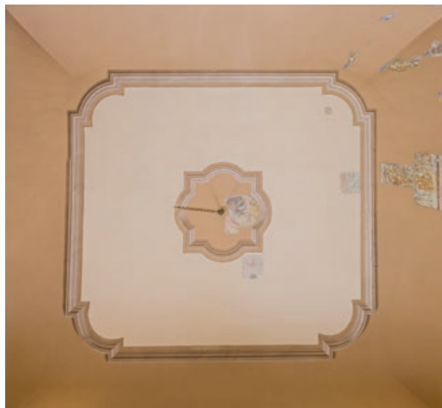
Soffitto della stanza prima dell'intervento
