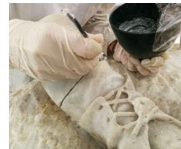
Operazioni di stuccatura
