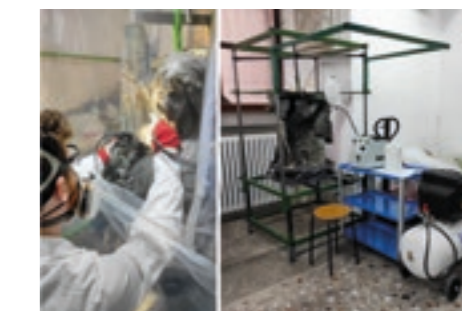
Intervento di micro-sabbatura e struttura di sostegno realizzata per le operazioni di restauro
