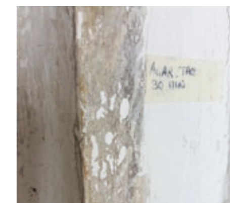
Fase di descialbatura della cornice
