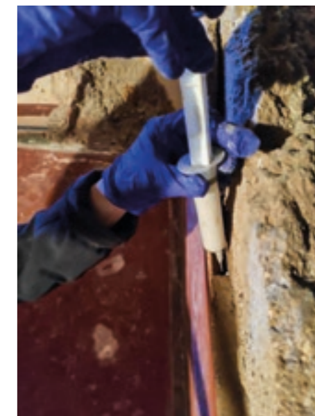
Iniezione di malta consolidante all'interno del distacco
