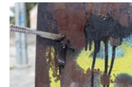
Asportazione tramite bisturi dello spesso strato di vernici dopo applicazione del calore
