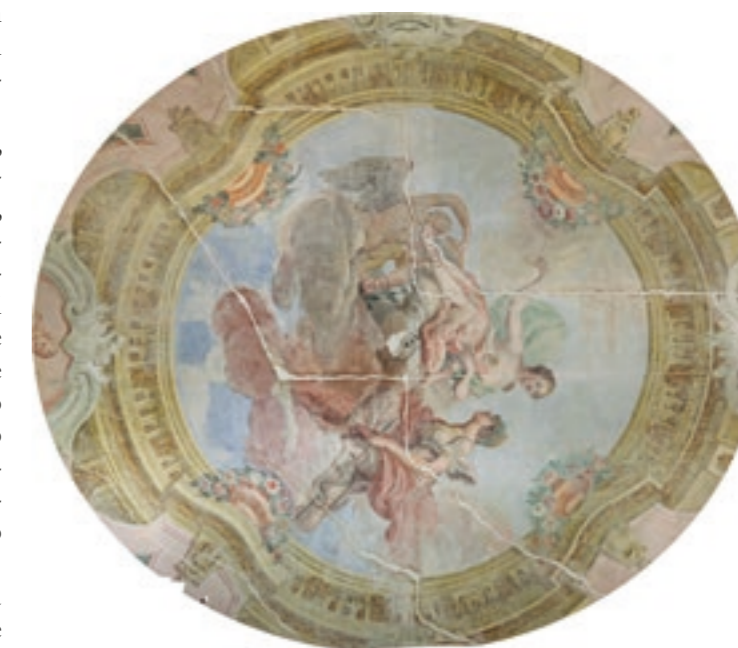
Porzione centrale del soffitto dopo la scopritura, pulitura e stuccatura
