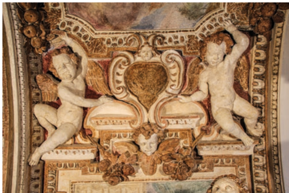
Particolare dopo il restauro
