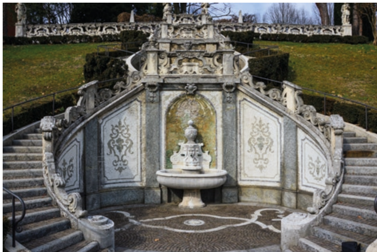
Il ninfeo prima del restauro
