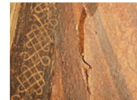
Particolare dei sollevamenti degli strati preparatori
