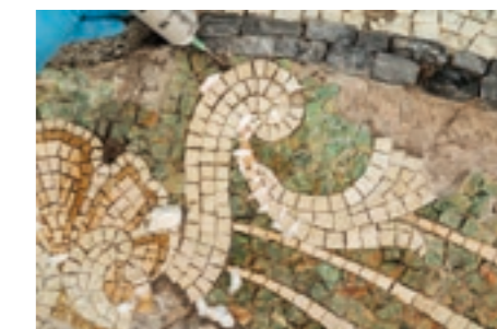
Riadesione dei distacchi tramite iniezioni di malta idraulica
