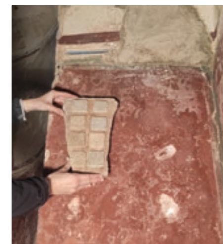
Prove di stuccatura con diverse tipologie di malte
