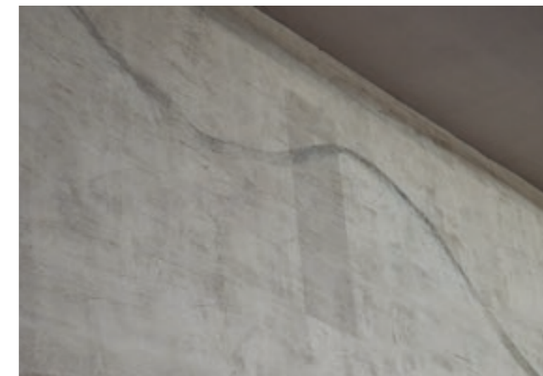
Durante la pulitura a secco con spugne in lattice vulcanizzato
