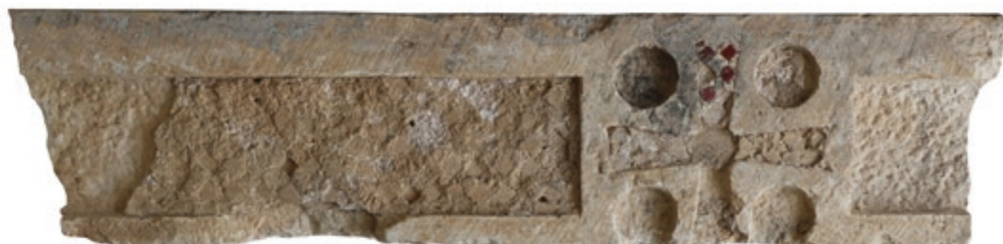
L'architrave prima del restauro
