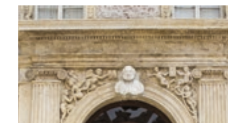
Pennacchi in altorilievo e busto, dopo l'intervento di restauro
