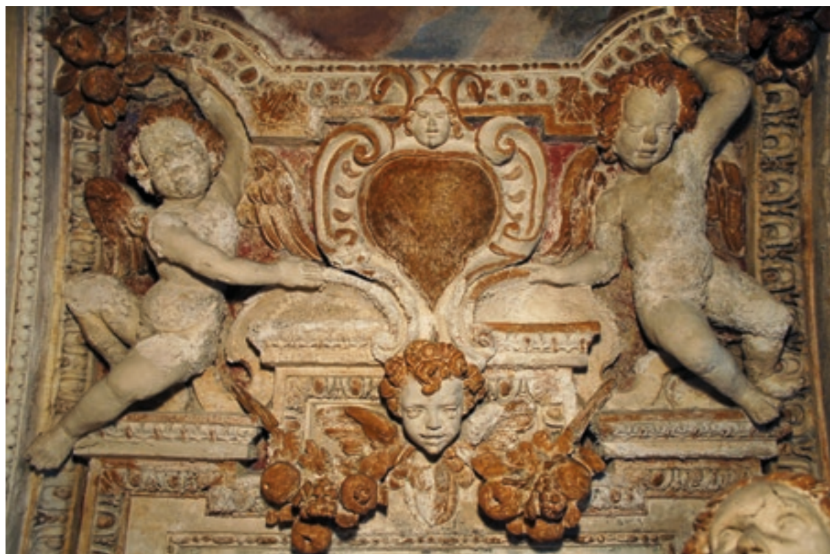
Particolare prima del restauro
