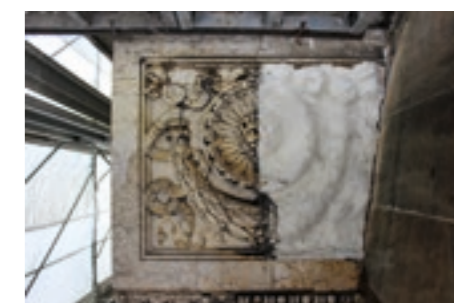
Pulitura a impacco degli elementi decorativi del prospetto laterale destro
